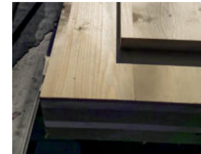
9 Dort, wo später die Wandplatten aufgestellt werden, ist ein breiter Falz ausgebildet.
