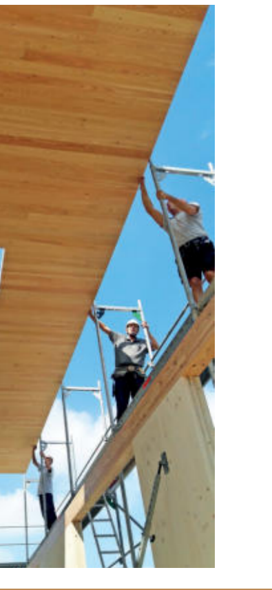
15 Zwischen Wandtafeln und Balken werden zuvor noch Komprimier-Dichtbänder aufgeklebt.
