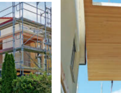
23 Von außen gesehen erkennt man ebenfalls die eigentlich simple Baukonstruktion – aus nur 5 großen Tafeln aus massivem Holz.
