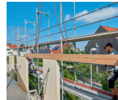
14 ... noch die langen Verbindungsbalken, die die drei Wandsegmente sicher zu einer Gebäudeseite zusammenfügen.
