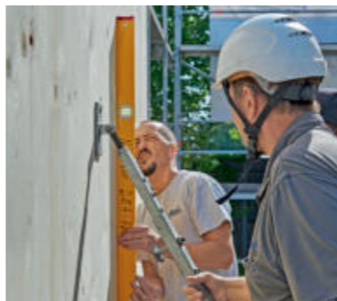
11 Mit in der Bodenplatte fixierten Drehstützen sind die Wandplatten schnell exakt ins Lot gebracht.
