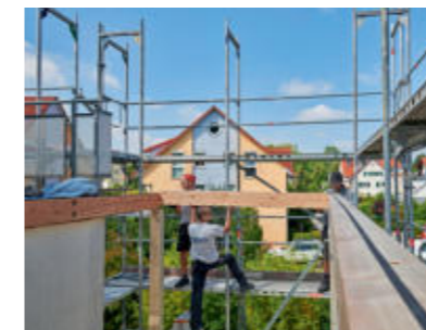
18 Dann folgen die Querverbindungen an den Kurzseiten des Anbaus, hier zur Gartenseite hin.
