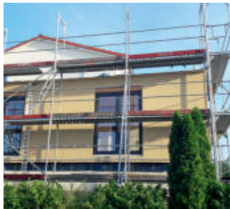
27 Die gesamte Außenfläche war damit wärmedämmtechnisch ausreichend eingepackt, bevor dann der ...
