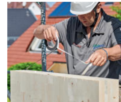
15 Zwischen Wandtafeln und Balken werden zuvor noch Komprimier-Dichtbänder aufgeklebt.
