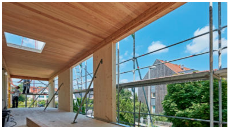
17 Die frei überstehende Wandpfette (s. Abb. 2) wird am Außenbeck mit einem Pfosten unterstützt.
