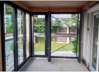
24 Richtung Osten, wo nur ein Stützpfeiler steht, bilden Drehtüranlagen übers Eck den Gebäudeabschluss.
