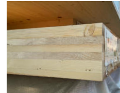
8 Und so sieht das kreuzlagenverleimte Brettsperrholz im Detail aus. Die Bodenplatte beispielsweise ist 16 cm dick.
