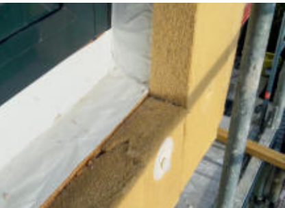
26 Außen wurden noch Holzfaser-Dämmplatten mit Tellern und Schrauben an den Holzwänden angeschraubt.
