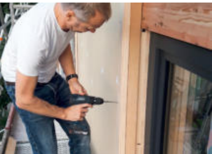
28 ... Bauherr die Wetterschutzverkleidung mit Fassadenplatten vorbereitet hat. Die massiven Kanthölzer ...
