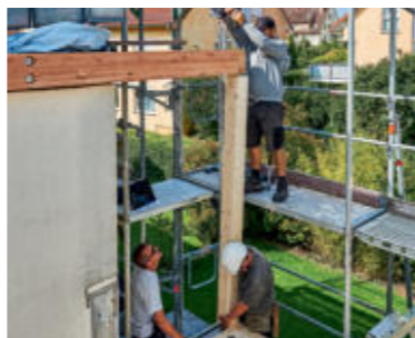
17 Die frei überstehende Wandpfette (s. Abb. 2) wird am Außenbeck mit einem Pfosten unterstützt.
