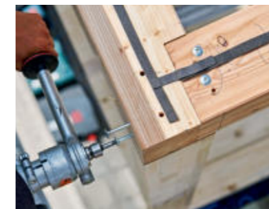
19 Seitlich eingebrachte Schrauben halten Quer- und Längspfetten zusammen. Die aufgeklebten Dichtbänder sorgen ...
