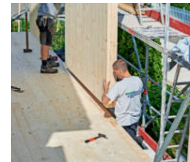
13 Mit insgesamt drei Seitentafeln ist der Anbau in Sachen Außenwandflächen im Prinzip fertig bestückt. Es fehlen nur ...
