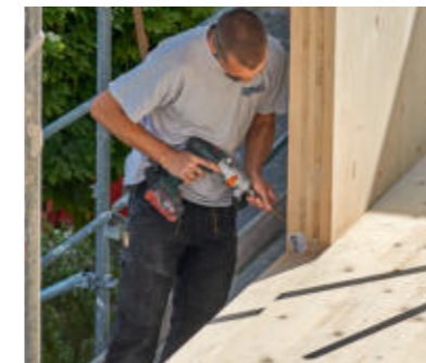
12 Mit von außen schräg eingedrehten Schrauben werden die Bauteile im Plattenfals verankert.
