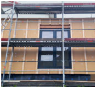
29 ... wurden im entsprechenden Abstand angebracht, so wie es die großen Platten dann erforderten.
