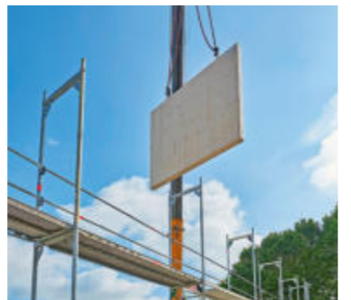
10 Und da ist dann auch schon das erste Wandsegment. Es sitzt auf der der Straße zugewandten Längsseite des Anbaus.
