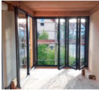
25 Gegenüber hat man sich für eine innenöffnende Falanlage entschieden, links davon für eine Schiebe-Abstelltür.
